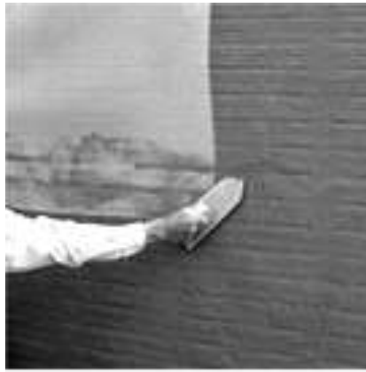
図 22 モルタル施工時のネット伏せ込み
